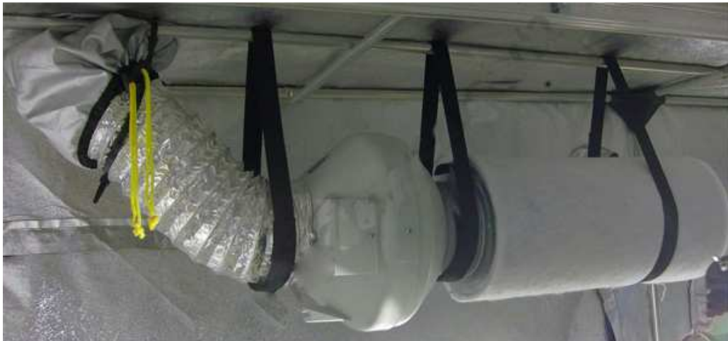
Extractor VK 150 con Filtro Pure Factory en interior armario
